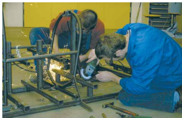
Schweißen der Rahmen-Tragvorrichtung (Foto: Weasels)
